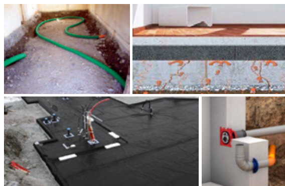
Misure di intervento per la riduzione delle concentrazioni del gas Radon nell'edificio ristrutturato.
