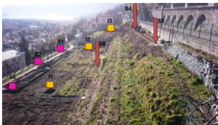
Fase iniziale del cantiere nel 2017 e posizioni delle prove geotecniche. A destra, fase finale del cantiere nel 2020.
