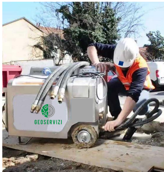
Fig. 1 Installazione attrezzatura GRT sul cantiere
