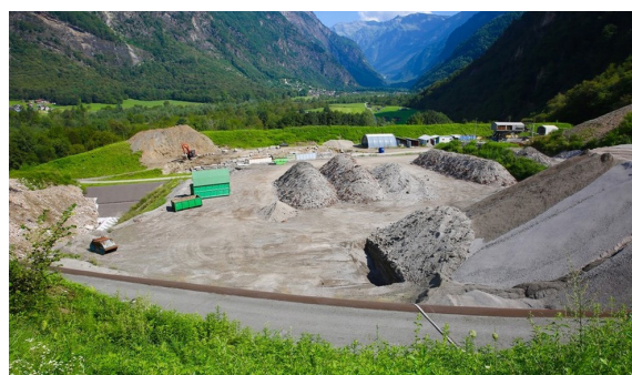
Realizzazione del sondaggio per il prelievo di un campione incontaminato, analisi di laboratorio e stoccaggio in discarica di tipo B.
