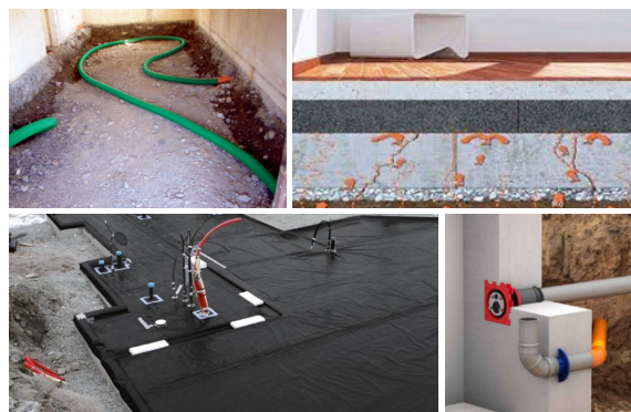
Misure di intervento per la riduzione delle concentrazioni del gas Radon nell'edificio ristrutturato.
