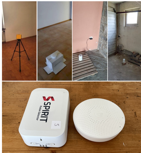
Strumenti di misurazione dell'edificio prima della ristrutturazione.
